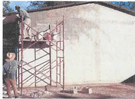
Foto 4: Impermeabilización, repello y pintura de la escuela de preprimaria.
